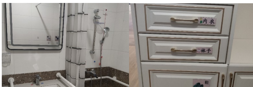
附图：洗手间扶手及红绳警报、家具上的各种标签提示
